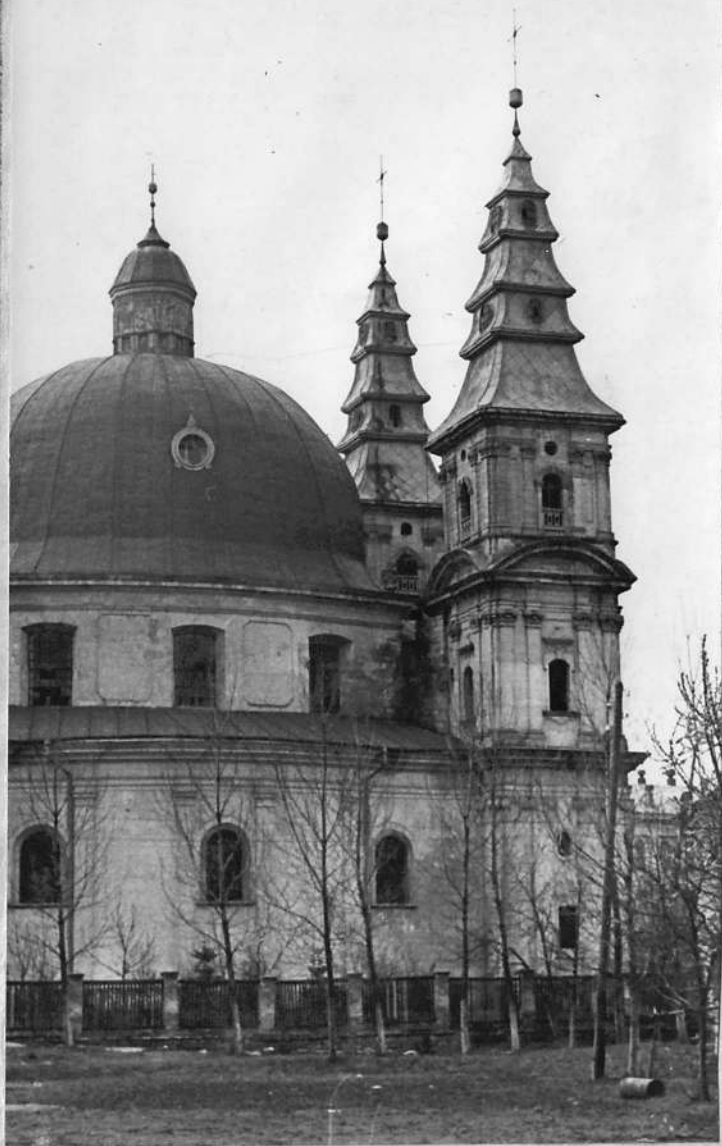
← 2. Фрагмент северо-восточного фасада.
