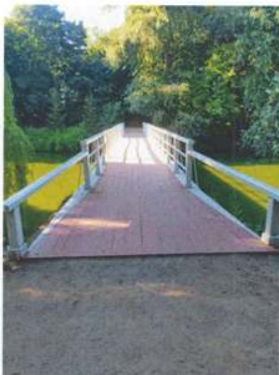
Міст дерев'яний на острові Анти-Цирцеї (Острів Кохання) (мур.), 1852 р., м. Умань, вул. Садова, 55 - адреса за наказом (вул. Київська, 12-а – сучасна адреса). Фото, 2021 р.
