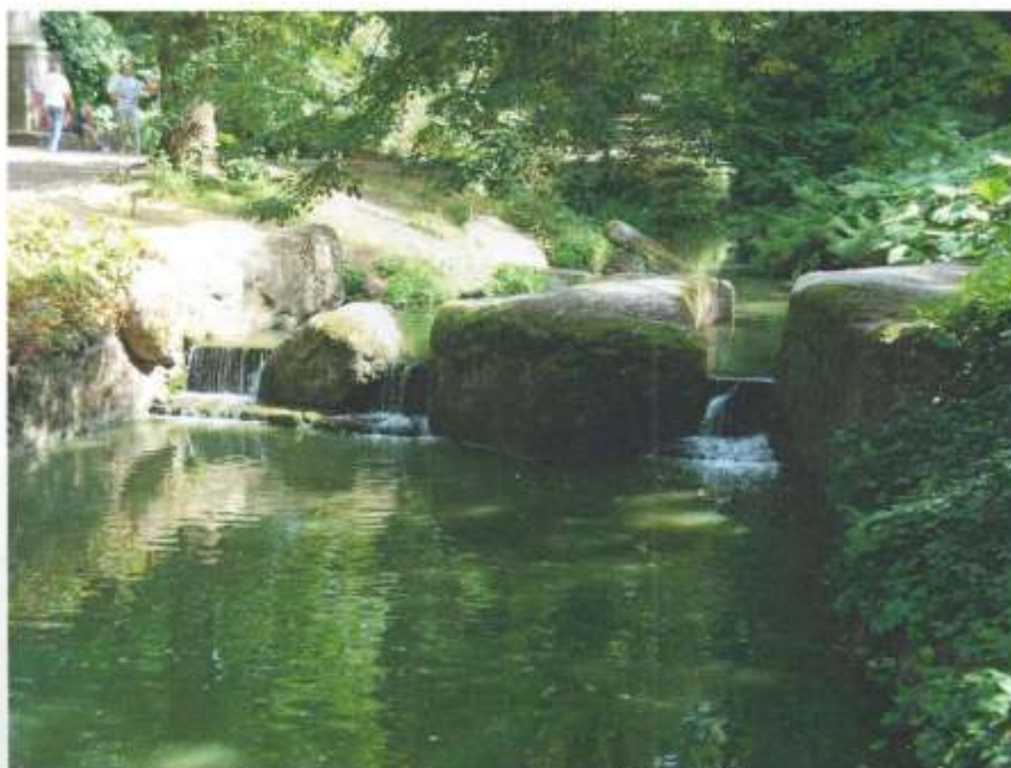
Каскад «Три Сльози» (мур.), 1796–1800 рр. м. Умань, вул. Садова, 55 - адреса за наказом (вул. Київська, 12-а – сучасна адреса). Фото, 2021 р.
