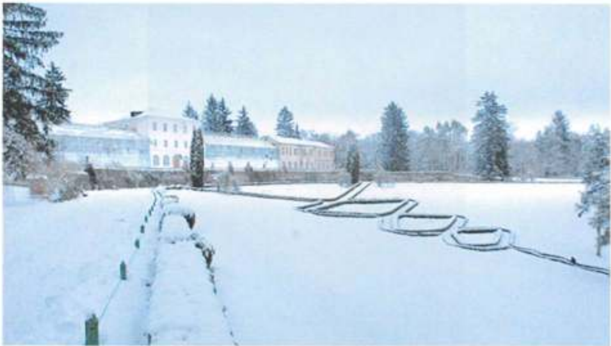
Гранітна стіна зі сходами до Літнього палацу з оранжереями, 1845 р. м. Умань, вул. Садова, 55 - адреса за наказом (вул. Київська, 12-а – сучасна адреса).
