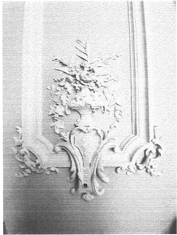
16. Ліпнина на стіні першого поверху.
