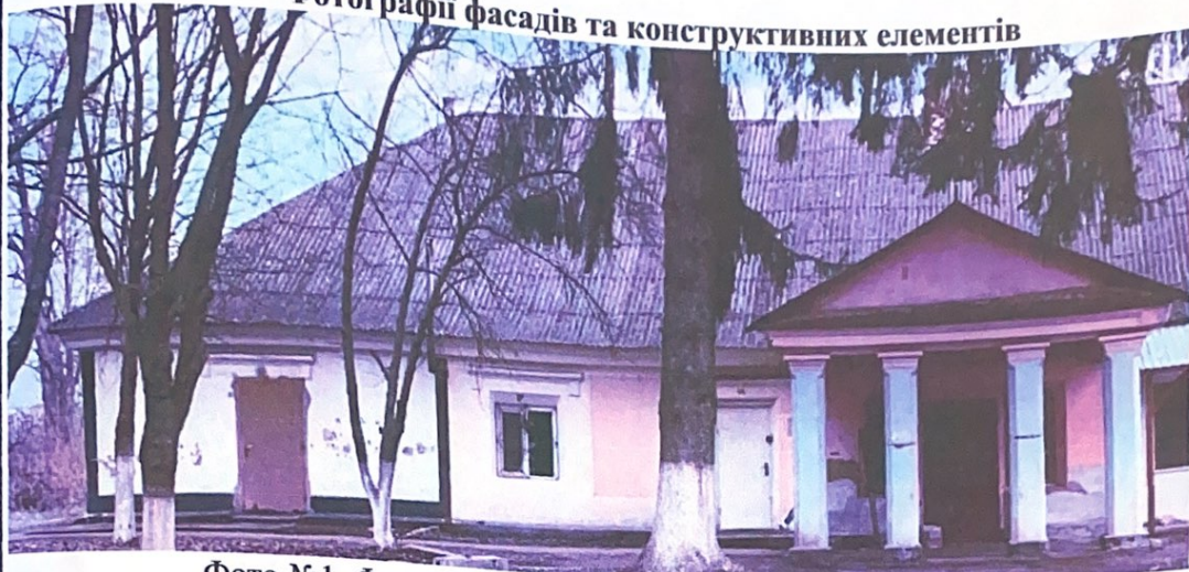
Фото №1: Фасад будівлі старої школи літ. «А» в осях 1-5.
