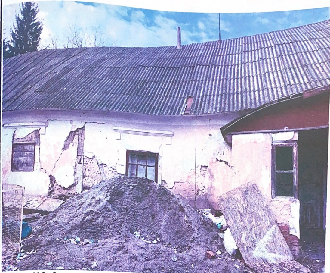
Фото №8: Фрагмент фасаду будівлі старої школи літ.«А» в осях Б-В, фрагмент фасаду тамбуру літ. «a1» в осях В-Г.
