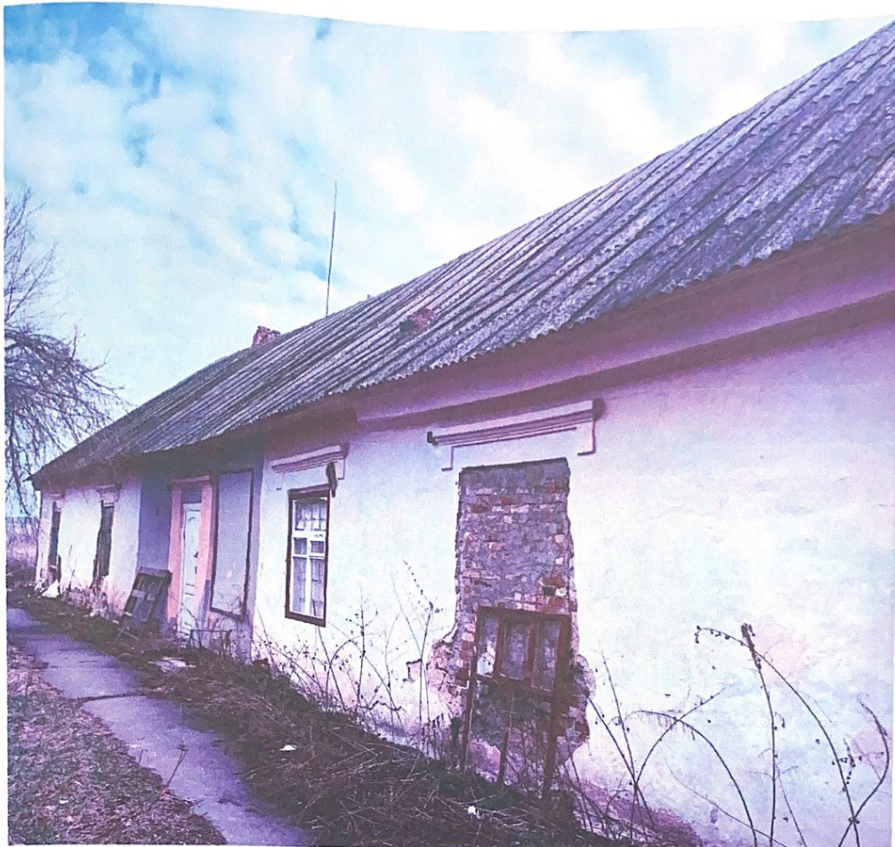
Фото №4: Фасад будівлі старої школи літ.«А» в осях В-Б вздовж осі 1.
