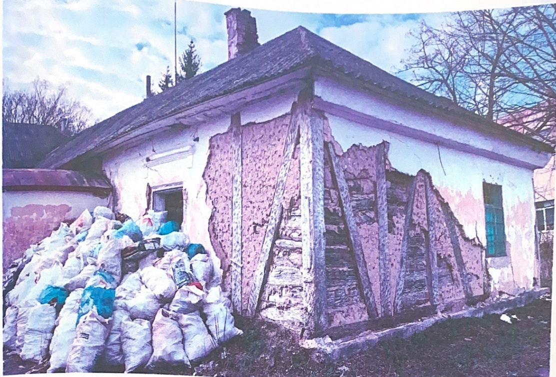
Фото №6: Фасад будівлі старої школи літ.«А» в осях Г-Д, вздовж осі Д.
