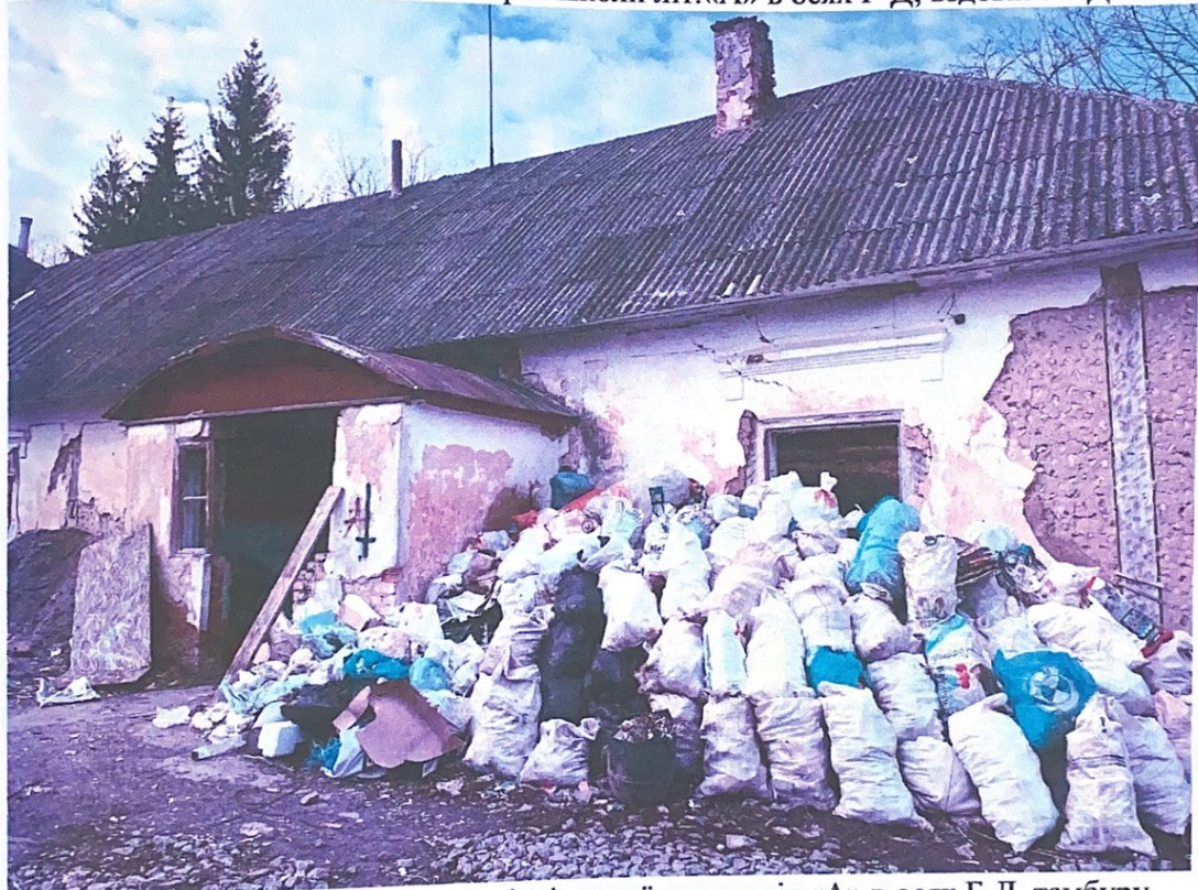
Фото №7: Фрагмент фасаду будівлі старої школи літ.«А» в осях Б-Д, тамбуру літ.«а1» в осях 3-2, вздовж осі Г.
