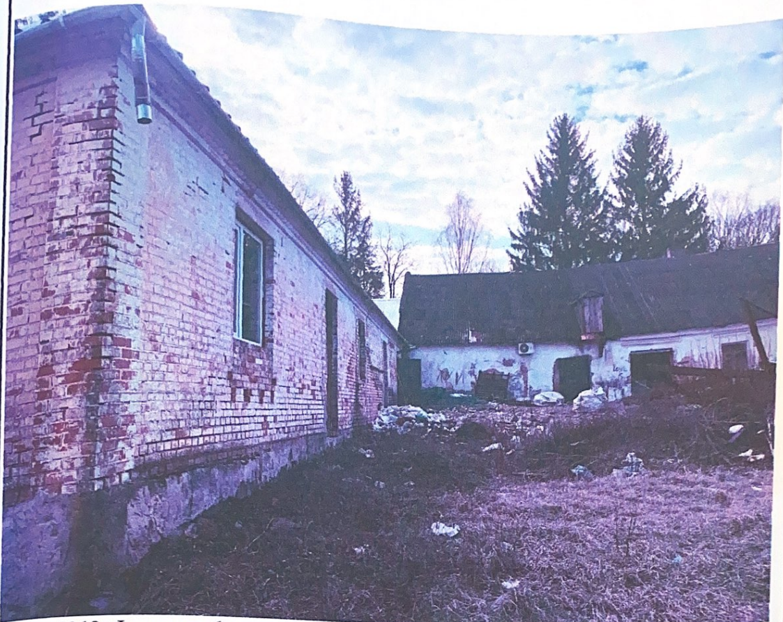
Фото №12: Фрагмент фасаду будівлі старої школи літ.«А» в осях 6-4, прибудови літ.«А1» в осях Е-Б.
