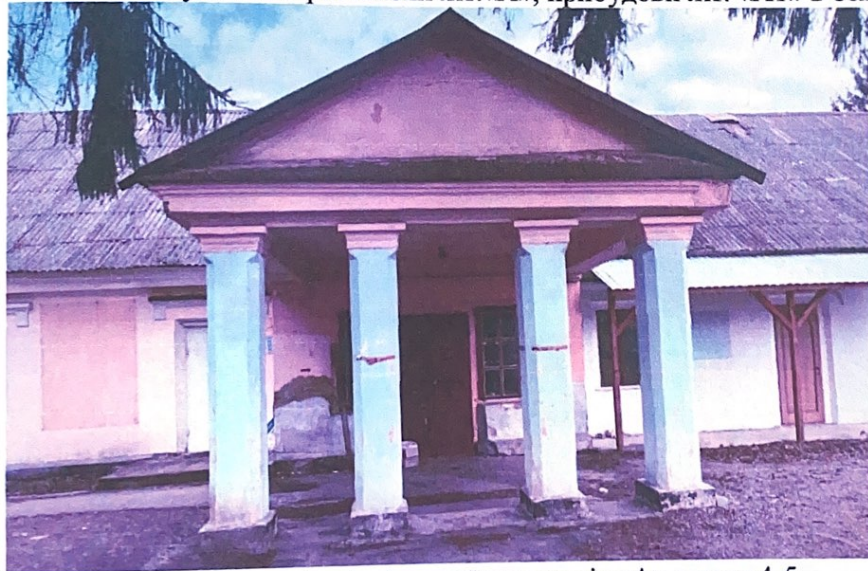
Фото №3: Фасад будівлі старої школи літ. «А» в осях 4-5.
