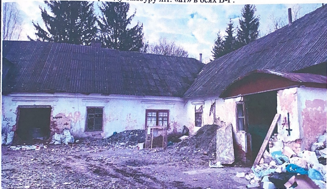
Фото №9: Фрагмент фасаду будівлі старої школи літ.«А» в осях 6-2, тамбуру літ.«a1» в осях В-Г.
