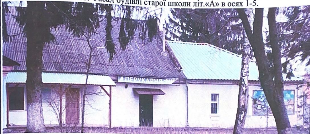
Фото №2: Фасад будівлі старої школи літ. «А», прибудови літ. «А1» в осях 5-8
