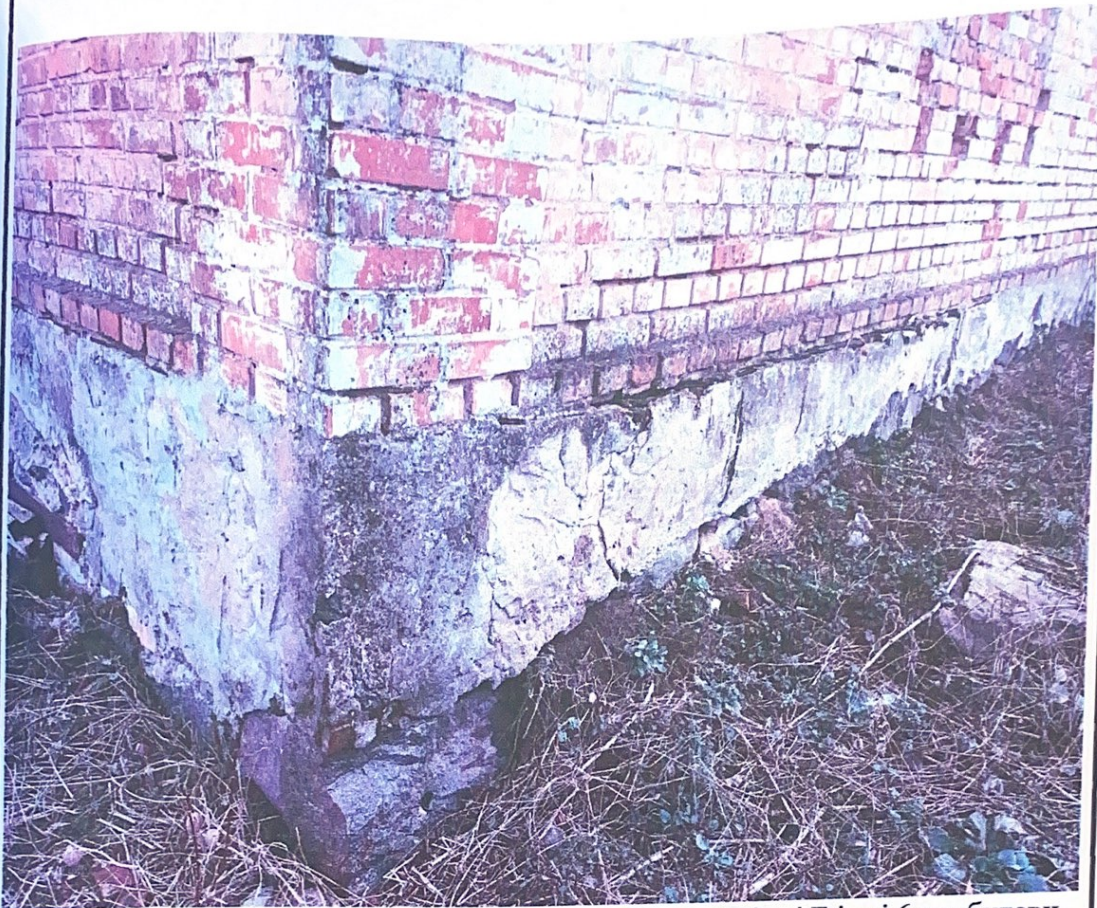
Фото №28 : Вертикальні тріщини в фундаменті на перетині осі Е і осі 6 прибудови літ. «А1».
