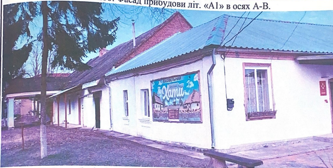
Фото №17: Фасад будівлі старої школи літ.«А» в осях 5-6, прибудови літ. «А1» в осях А-Б, 7-8.
