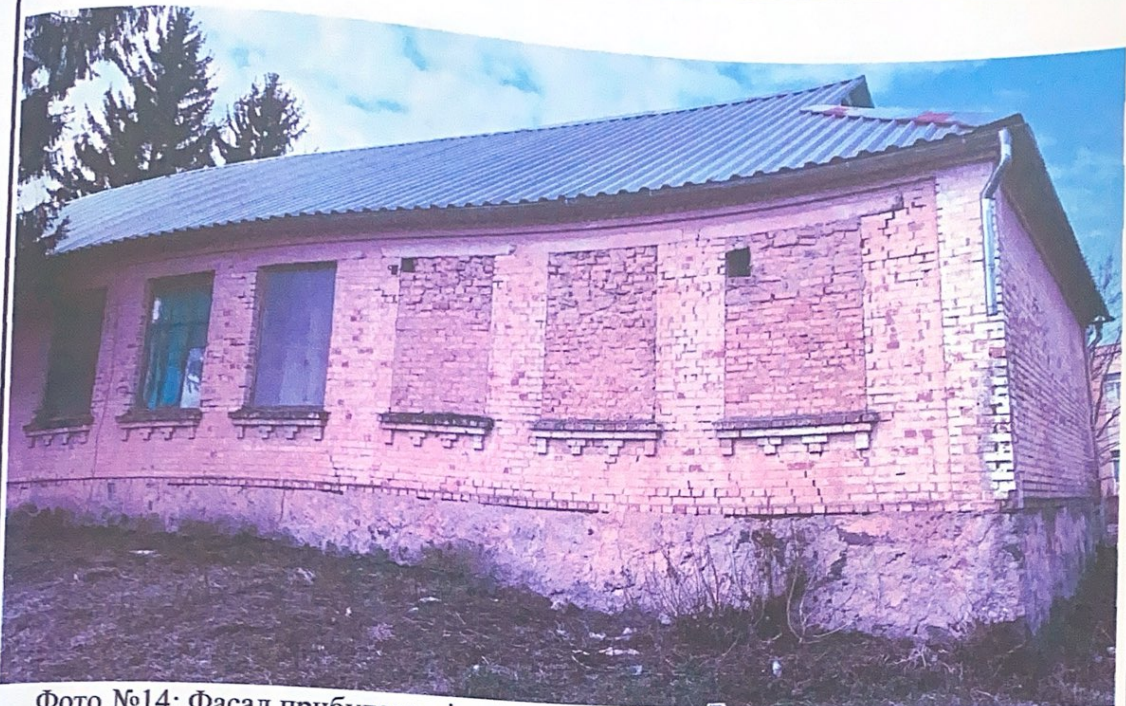
Фото №14: Фасад прибудови літ.«А1» в осях 8-6, фрагмент фасаду в осях Е-Б.
