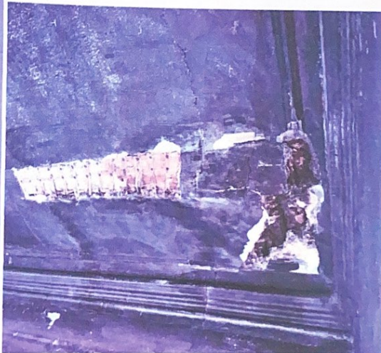
Фото №26,27 : Вертикальні та горизонтальні тріщини в стінах і перекритті приміщень 12, 29 будівлі старої школи літ.«А».
