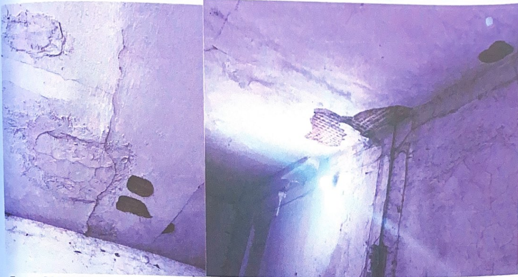
Фото №21,22: Прогин перекриття в приміщенні 27 будівлі старої школи літ. «А», осипання штукатурки перекриття.
