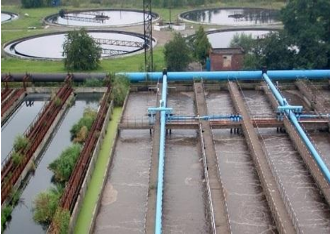
Очисні споруди ЛМКП «Львівводоканал»
