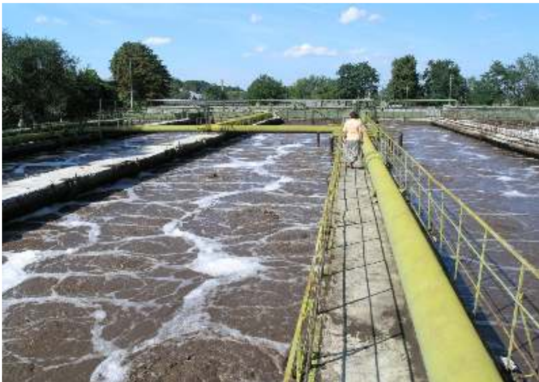
Очисні споруди ЛМКП «Львівводоканал»
