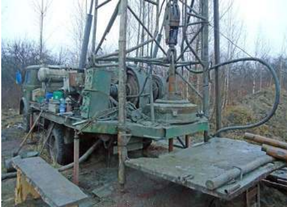
Проведення робіт з тампонажу недіючих артезіанських свердловин
