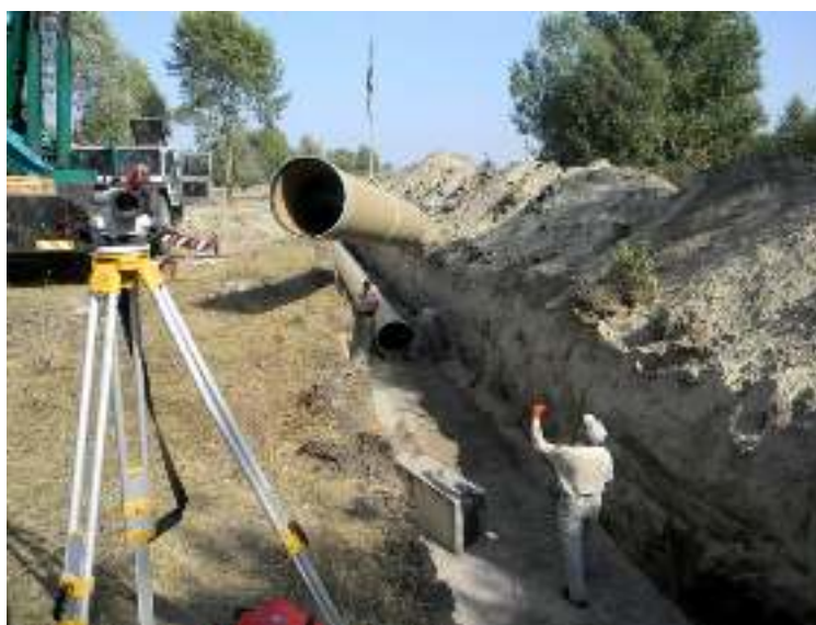
Будівництво напірного каналізаційного трубопроводу по наливній території «Лісковиця»
