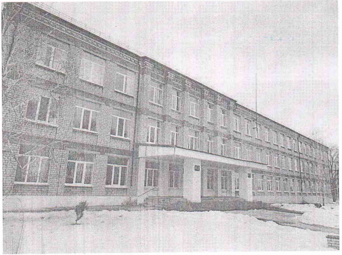
Фото В.1. Головний фасад будівлі учбового корпусу за адресою: вул. Щаслива, 1н, вісі «А/1-17»
