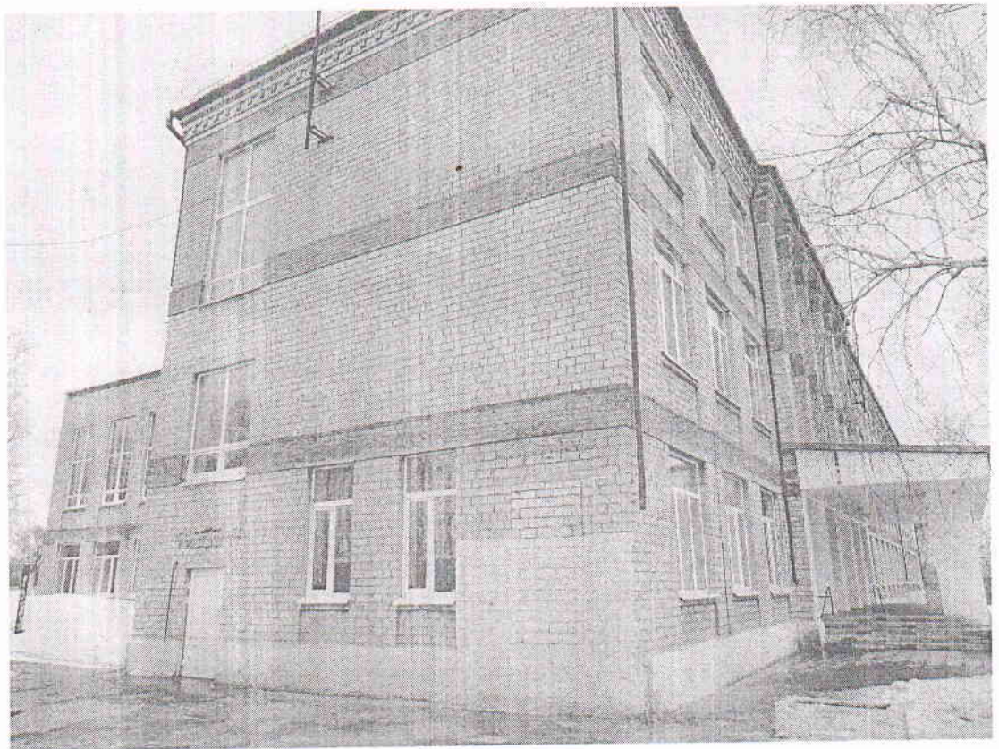
Фото В.2. Боковий фасад будівлі учбового корпусу, вісі «1/А-В»
