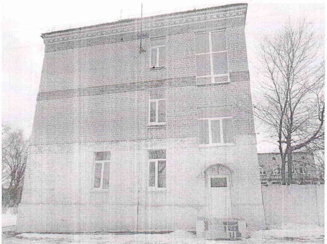
Фото В.4. Боковий фасад будівлі, вісі «17/А-Г»
