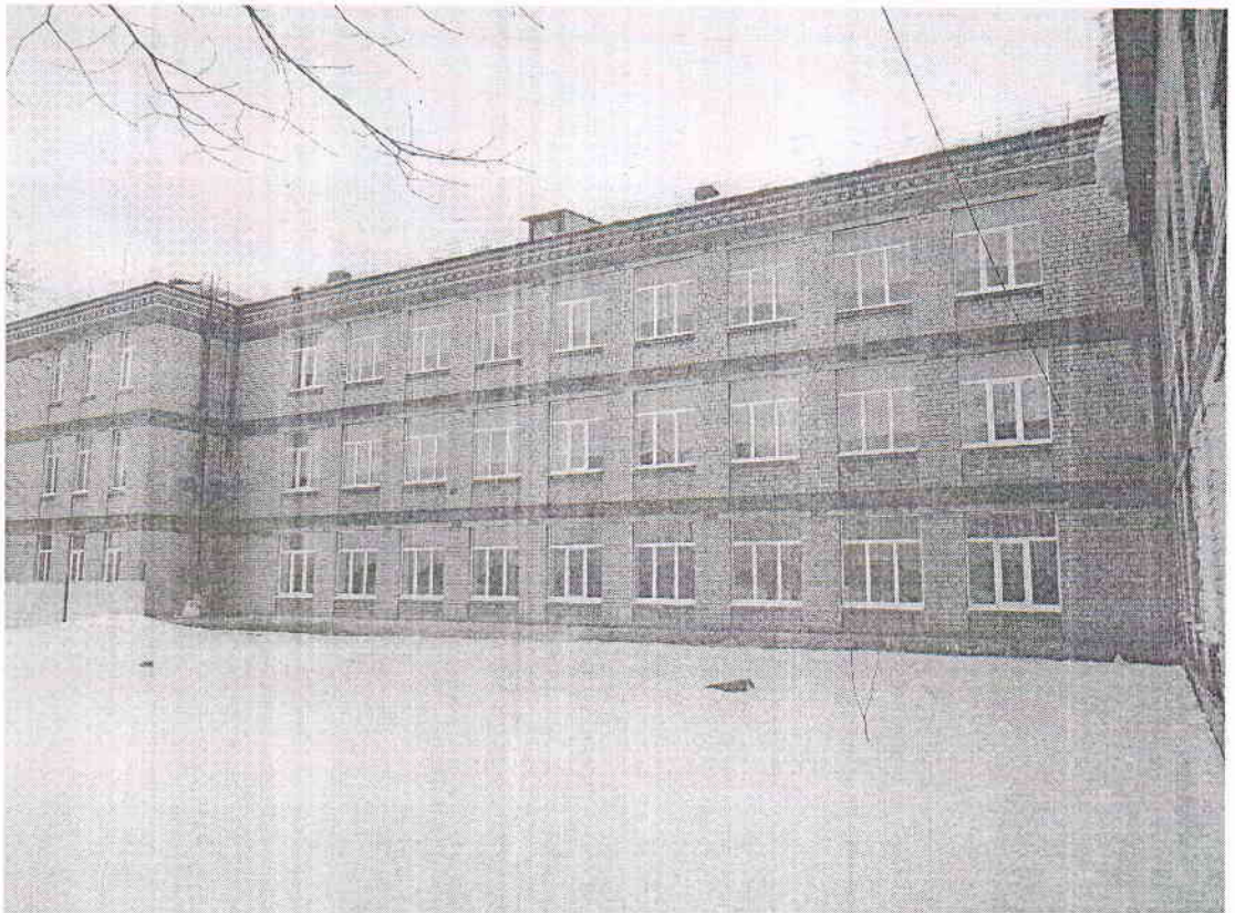
Фото В.3. Фрагмент фасаду будівлі, вісі «Г/17-14», «В/14-9»
