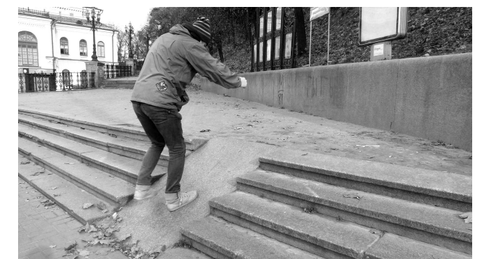
ПІДЗЕМНІ ПЕРЕХОДИ, СУЦІЛЬНЕ ПАРКУВАННЯ ТА КРУТІ ПАНДУСИ ПЕРЕШКОДЖАЮТЬ ПОТРАПЛАННЮ ДО ПАРКУ
