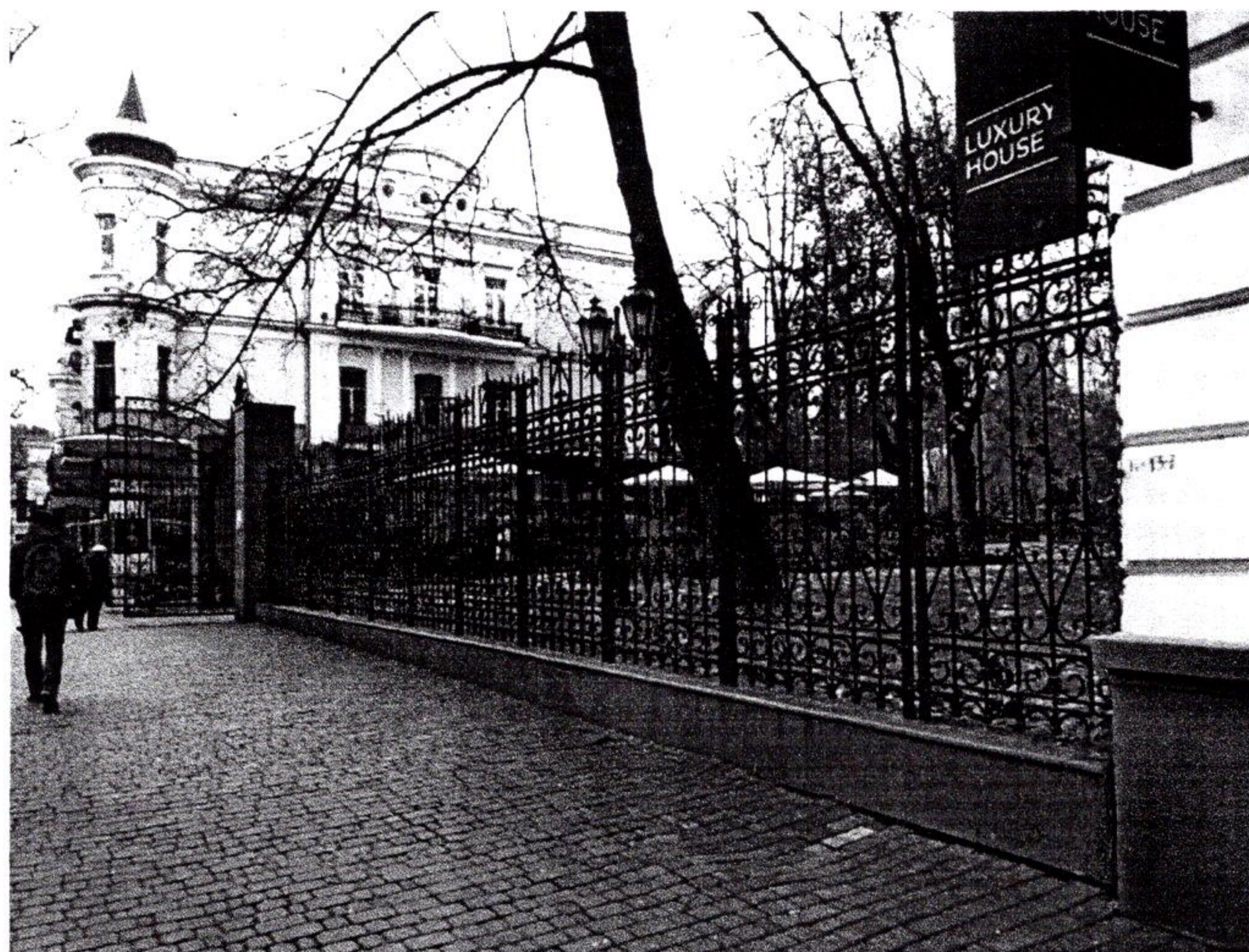
Огородження Міського саду з боку вул. Гаванної
