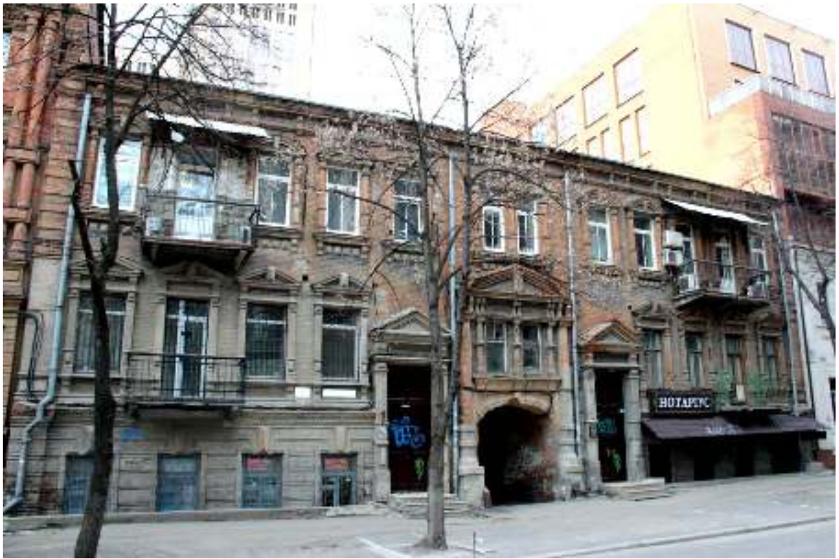
Прибутковий будинок вул. Барикадна, 11-А
