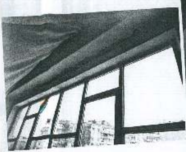
8. Ремонт актовой зали (облаштування сцени, заміна дверей тощо)
