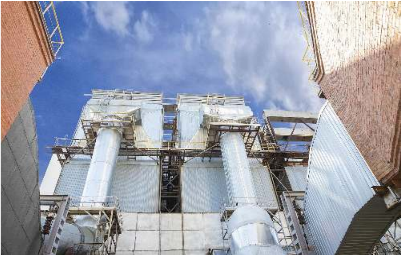
Рис. 14 Сміттєспалювальний завод «Енергія» КП «КИЇВТЕПЛОЕНЕРГО»
