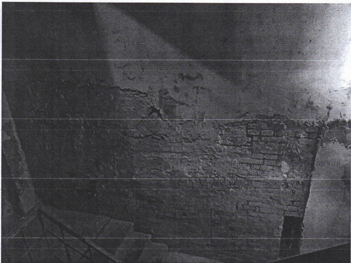
Фрагмент інтер'єру сходової клітини. Ділянка відшарування тиньку зі стіни.
