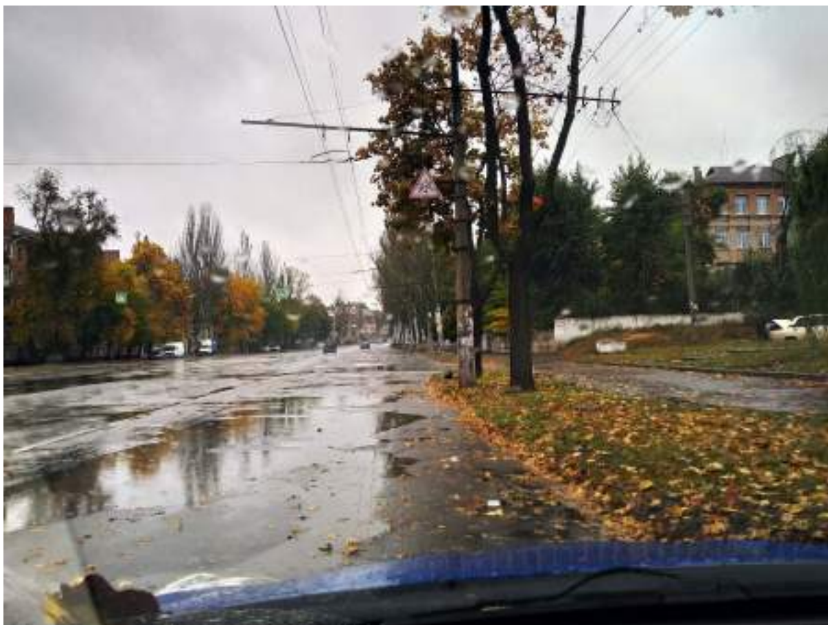
Фото 2. Стан основної проїзної частини (деформація покриття, бортових каменів, ненормативний поперечний та поздовжній похили)
