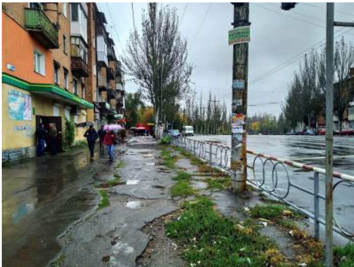
Фото 4. Стан пішохідної частини тротуару (деформація покриття, наявність перешкод на пішохідній зоні)
